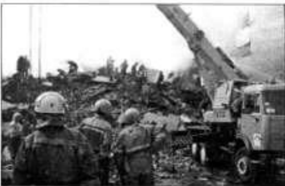
2002 г. Северо-Западный РЦ, Санкт-Петербург. ПСР при обрушении жилого дома
