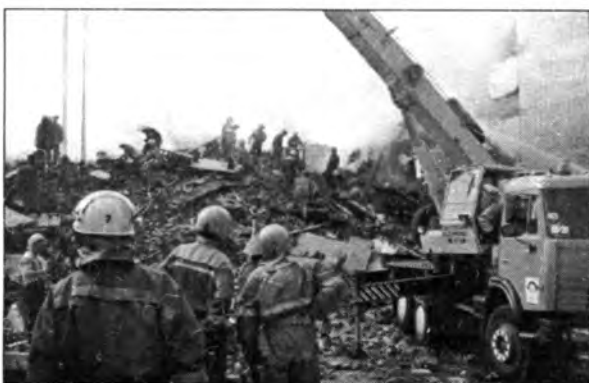
2002 г. Северо-Западный РЦ. Санкт-Петербург. ПСР при обрушении жилого дома
